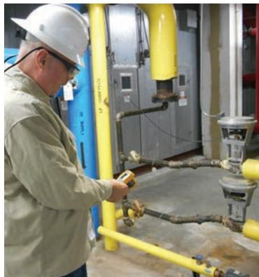
Tester le purgeur de vapeur pour voir si le purgeur a eu une défaillance en position ouverte et gaspille de la vapeur.
