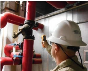
Mesurer la température d'eau à l'entrée d'un serpentin d'un système de traitement de l'air.
