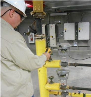
Mesurer la température de vapeur à l'entrée de la soupape d'humidificateur.
