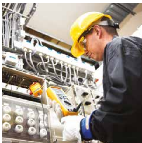
Portez des équipements de protection, tels que des lunettes de sécurité et des gants isolés.
